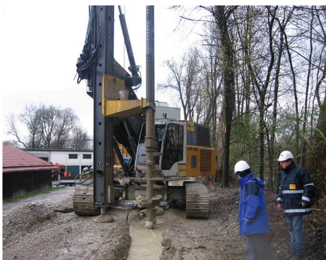
Oben: Überströmung einer Dichtwand an der Iller in Fischen während des Hochwassers 2005; Unten: Einbau einer Dichtwand als tiefreichende Bodenvermörtelung (Hochwasserschutz Mangfall)
