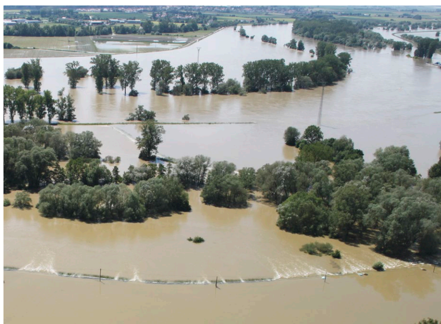
Grenzen des Hochwasserschutzes: Überströmter Deich an der Donau
